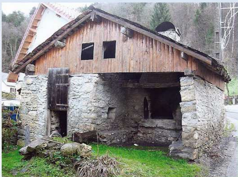
Four de Tigneux construit en 1837
